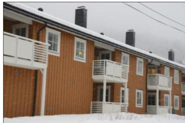
SVARTØYMOEN: Støren har fått flere leilighetsbygg som kan være attraktive for førstegangskjøpere.
